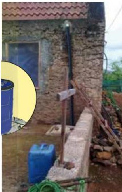
Figura 7. Sistema de captação da água das chuvas do telhado
