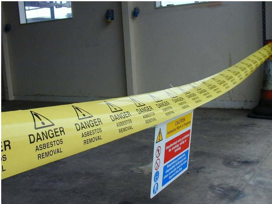
Figura 18. Utilização de fita (com a menção «Perigo Remoção de Amianto») e sinais de aviso para delimitar a zona)
