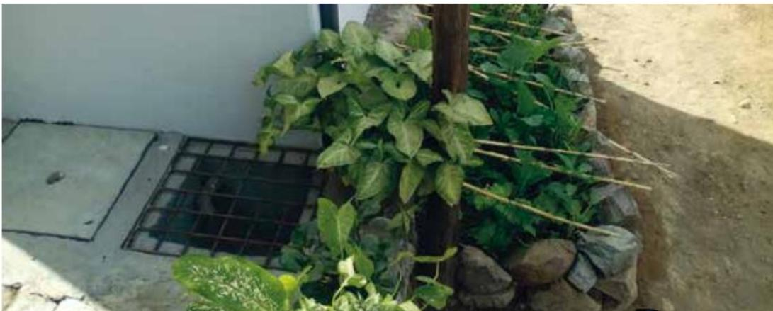
Figura 12. Caixa de recolha das águas cinzas
