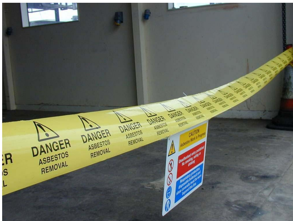
Figura 3. Utilização de fita (com a menção «Perigo Remoção de Amianto») e sinais de aviso para delimitar a zona)
