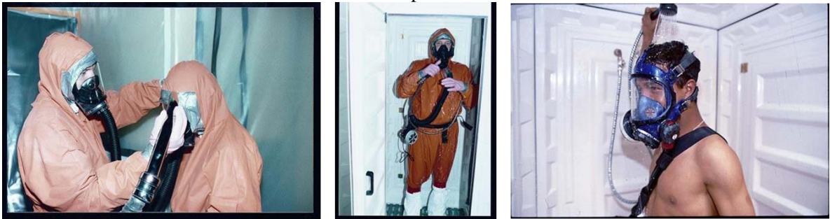
Figura 10. Descontaminação com aspirador de tipo H, no chuveiro com fatos-macaco impermeáveis e banho de chuveiro antes da remoção do equipamento de proteção respiratória
