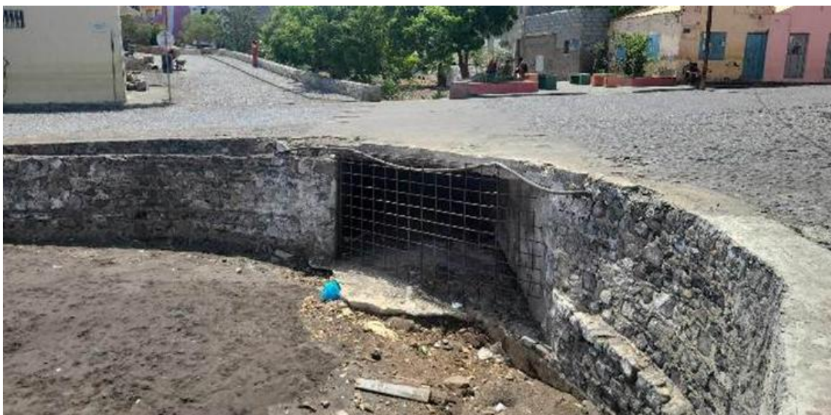
Figura 16: Primeira Bacia Hidrográfica, localizado logo à entrada da avenida. Fonte: Elaboração própria.
