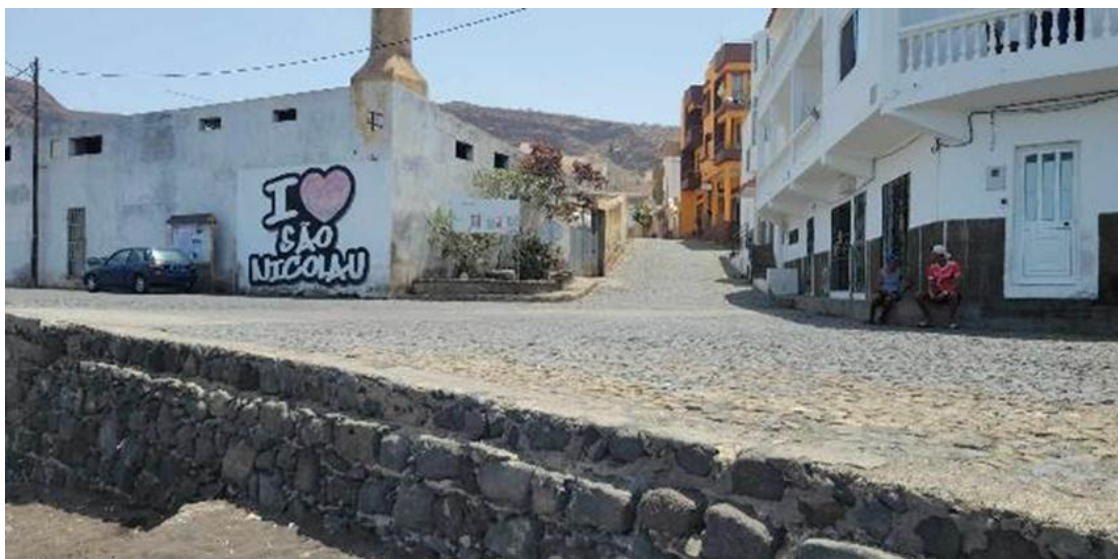
Figura 24: Muro que separa a fábrica da orla marítima. Fonte: Elaboração própria.
