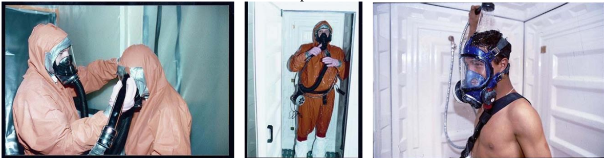
Figura 26. Descontaminação com aspirador de tipo H, no chuveiro com fatos-macaco impermeáveis e banho de chuveiro antes da remoção do equipamento de proteção respiratória
