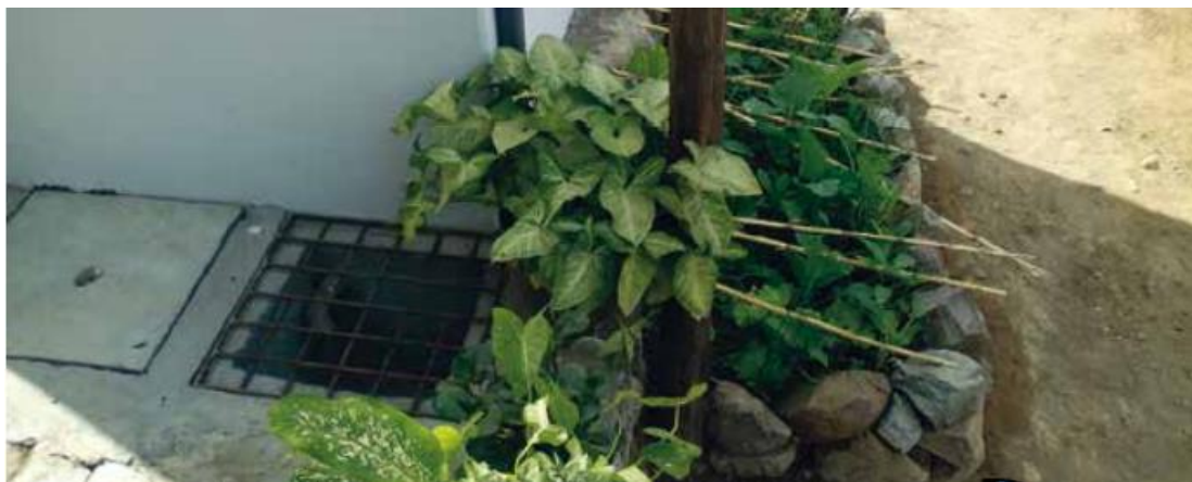
Figura 13. Caixa de recolha das águas cinzas
