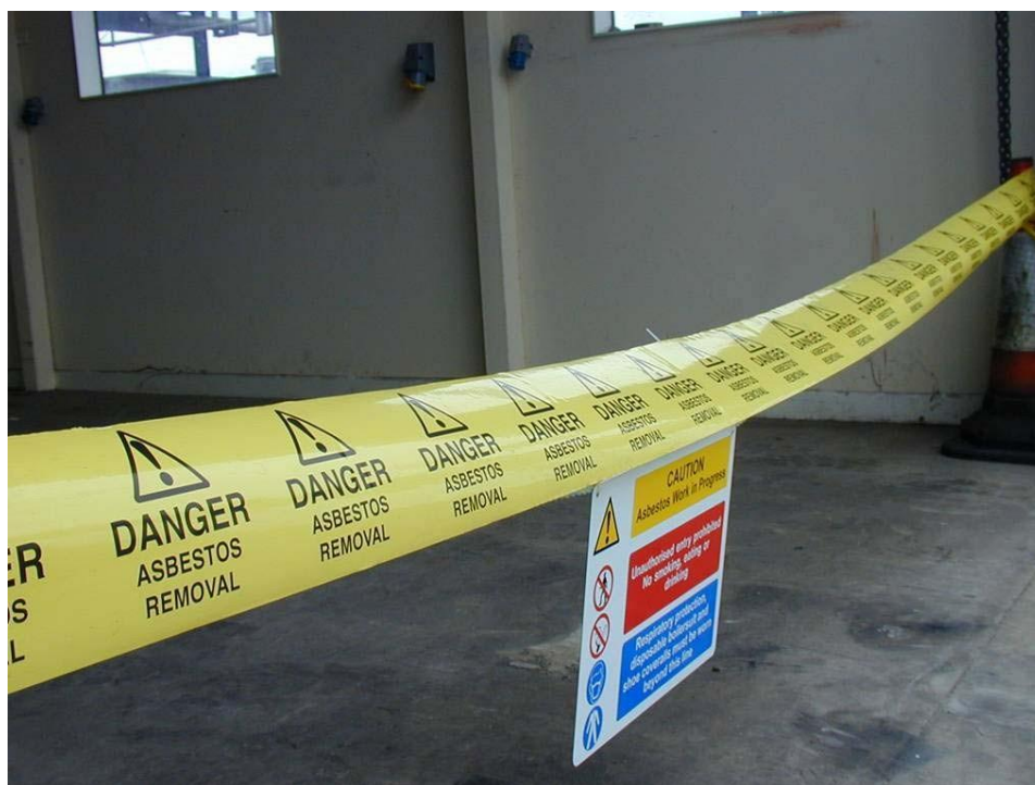
Figura 19. Utilização de fita (com a menção «Perigo Remoção de Amianto») e sinais de aviso para delimitar a zona)
