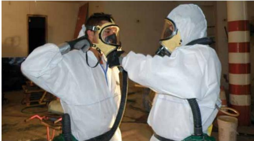
Figura 21. Trabalhadores com equipamentos de proteção respiratória
