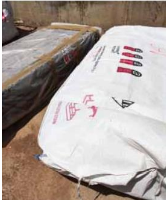
Figura 28. Resíduos da demolição acondicionados
