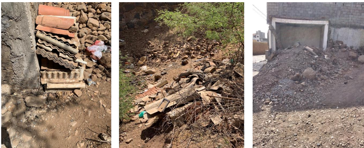
Presença de resíduos de construção pré-existent às intervenções do projecto, podendo conter materiais perigosos
